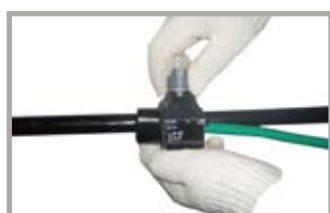
2. 将线夹固定在主电缆分支处
